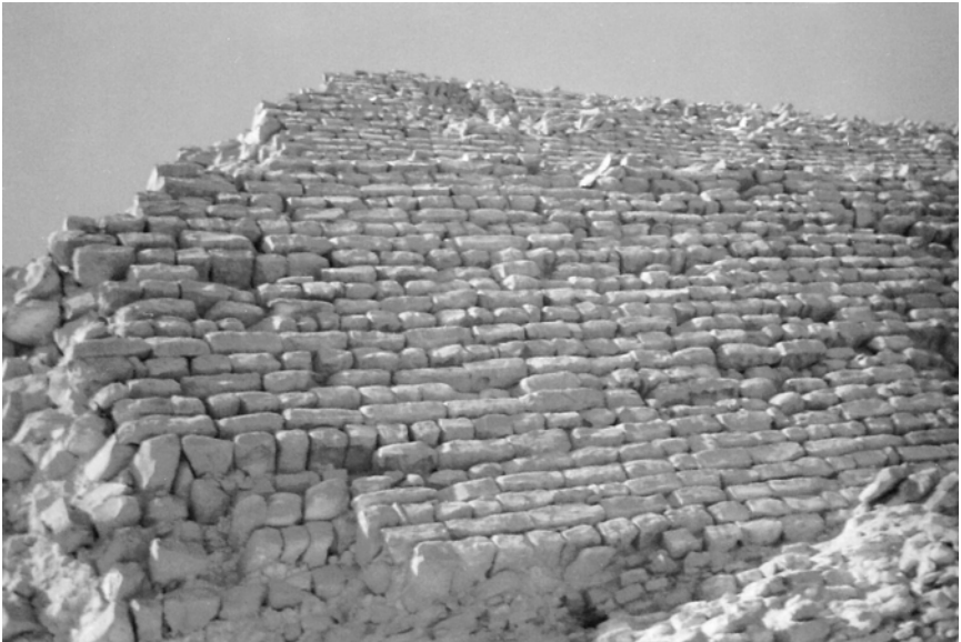
Illustration 1.2 Blocs de noyau de calcaire dans la pyramide à degrés, en forme de brique de boue
