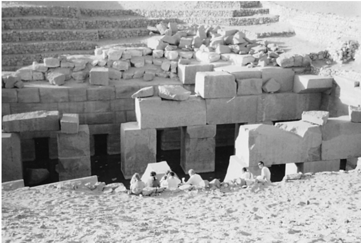
Illustration 7.16 De grands blocs de pierre ajustés avec précision à leurs piliers de soutien dans l'Osireion à l'arrière du temple d'Abydos
