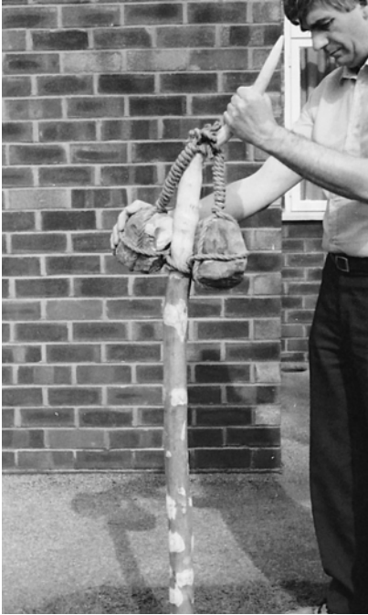
Figure 5.21 Une torsion dans le sens des aiguilles d'une montre d'un grand arbre de forage
