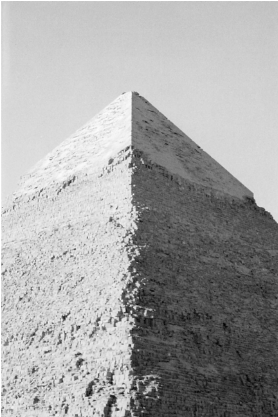
Illustration 7.15 Blocs de tubage ajustés avec précision au sommet de la pyramide de Khafré à Gizeh
