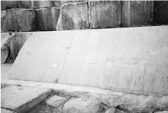
Figure 7.1 Grands blocs de coffrage calcaire au pied du côté nord de la Grande Pyramide
