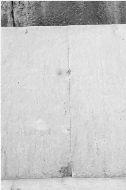
Illustration 7.7 Un joint montant entre deux grands blocs de tubage dans la Grande Pyramide
