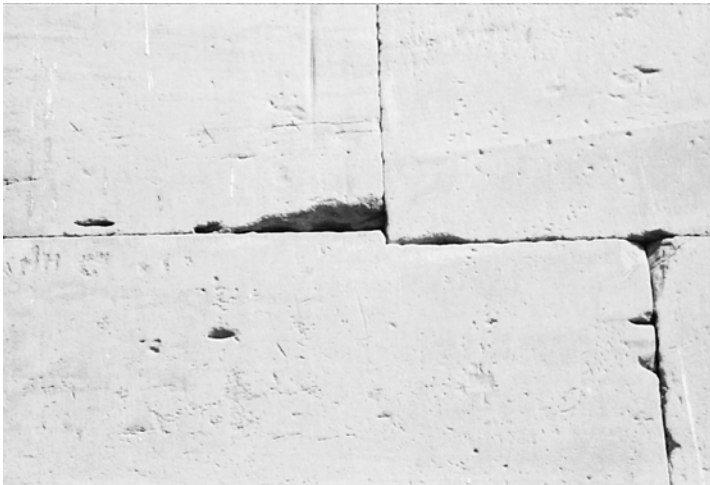
Illustration 7.14 De grands blocs de pierre ont été fabriqués pour s'adapter aux blocs adjacents
