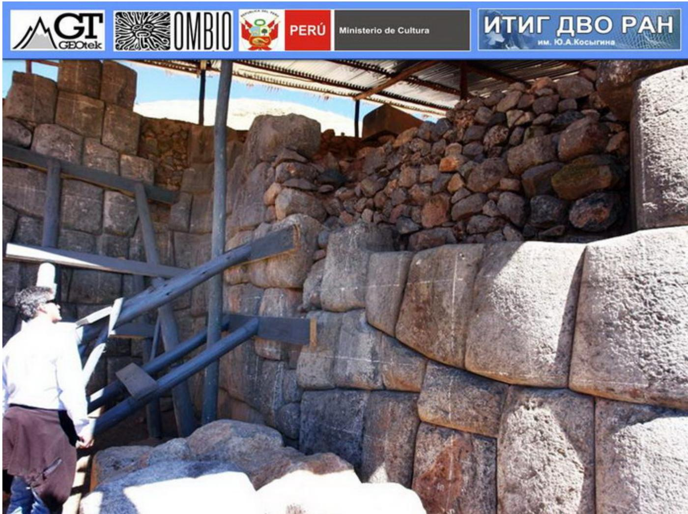
Sur la base des données obtenues, on peut conclure que pour éviter la destruction du mur, il est nécessaire d'examiner le sol à la base, d'identifier toutes les zones de fracture et de tracer leur continuation. A partir des données sur la position des zones de fracture qui collectent les eaux de surface et s'écoulent le long de la pente naturelle, il est nécessaire d'organiser l'interception du drainage des eaux de surface et de les détourner de
