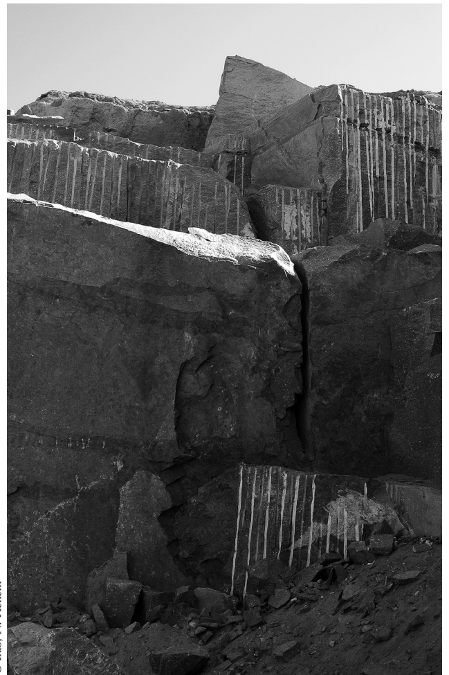
FIG. 12. Front de masse tranché récemment à l'aide du « jeu de flamme », dans la carrière du Gebel al-Mesalla (profondeur de la tranchée: 3 m; largeur: 20 à 25 cm environ).
