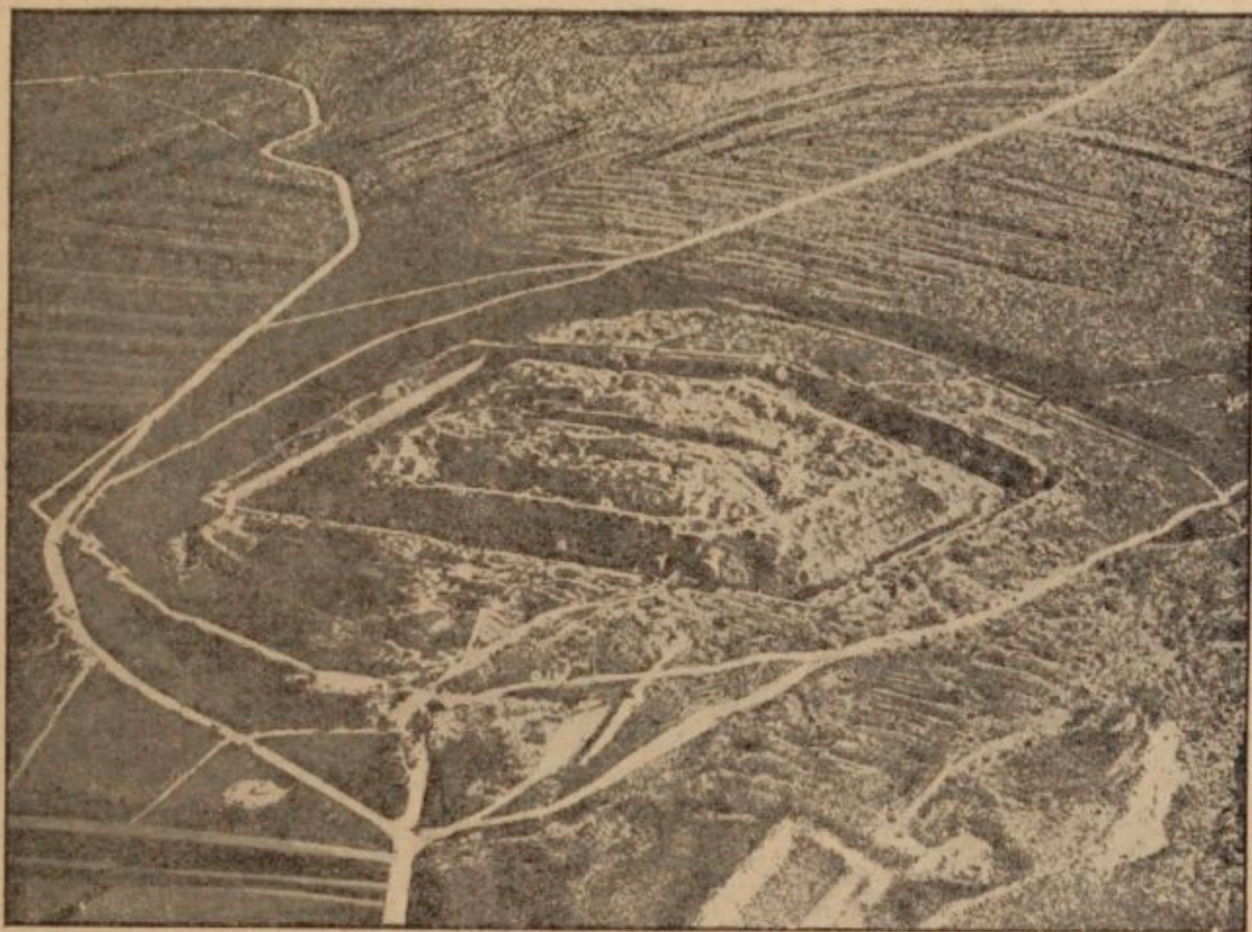
LE FORT DE MANONVILLERS, VUE PRISE D'UN AVION. On peut constater que le fort est complètement rasé.
