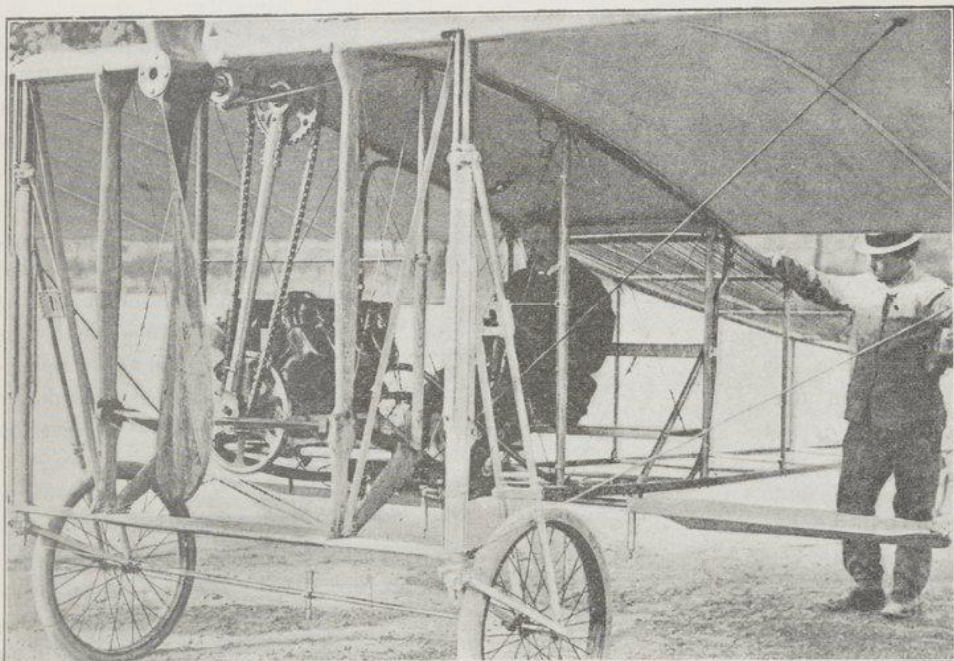
Fig. 486. — Dispositif d'atterrissage du monoplan Blériot (modèle traversée de la Manche).
