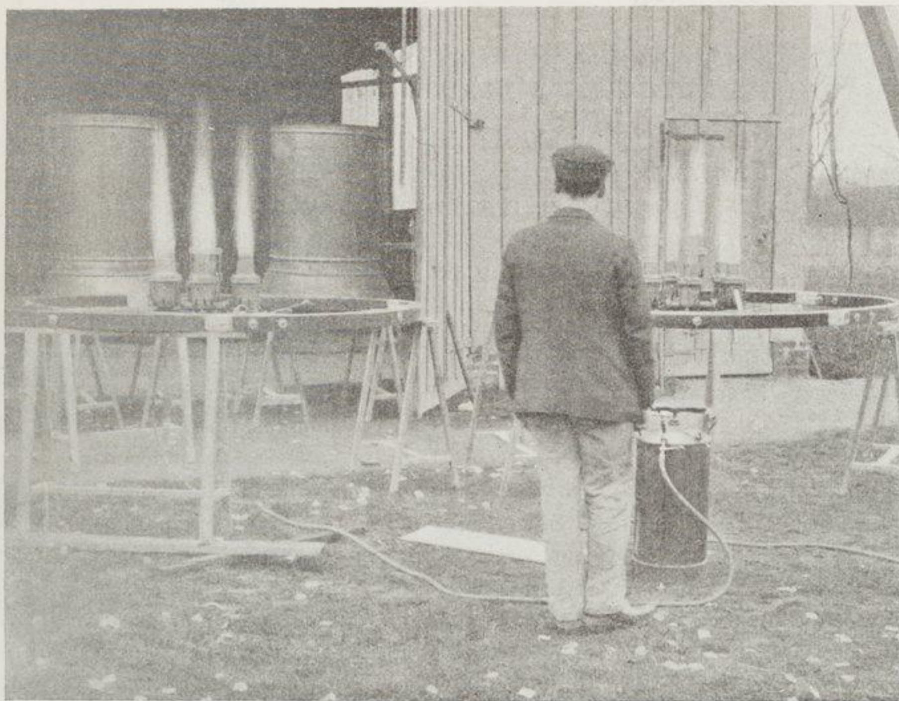
Fig. 140. — Montage d'ensemble des brûleurs sur le cercle d'une montgolfière Louis Godard.
