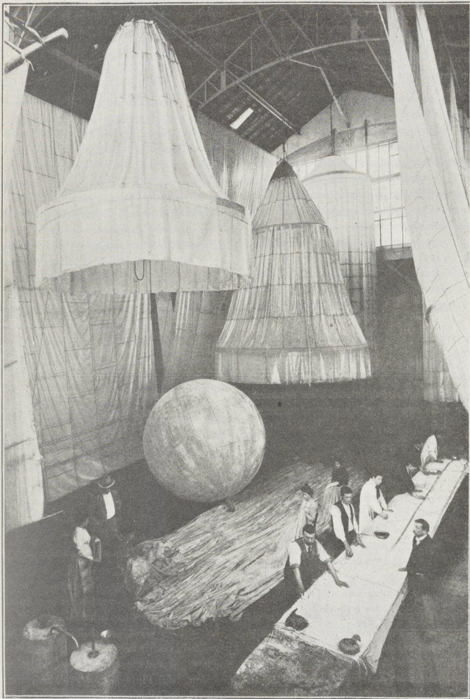
Fig. 235. — Fabrication des enveloppes de dirigeables aux ateliers Lachambre.
