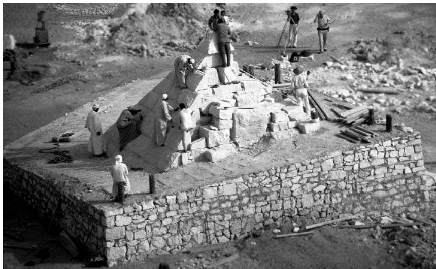
Figure 82: vue générale de la mini pyramide de Nova; la gigantesque rampe enveloppante démontre la difficulté du scénario avec les rampes qui nécessitent une énorme quantité de matériaux (1991).
