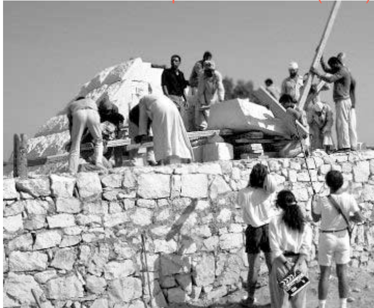
Figure 81: l'équipe de tournage de Nova (premier plan) filmant les efforts désespérés pour lever un bloc de pierre avec des leviers en bois. Il fallut aux ouvriers plus de cinq heures pour lever la pierre depuis le niveau de la rampe jusque sur la pyramide (1991).
