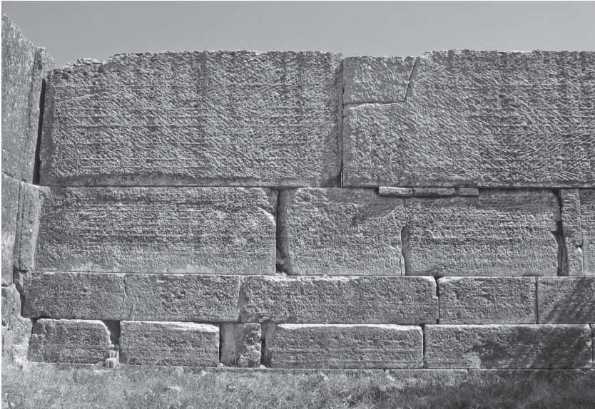
Fig. 5 – Le péribole, face sud du mur nord, tronçon occidental.
