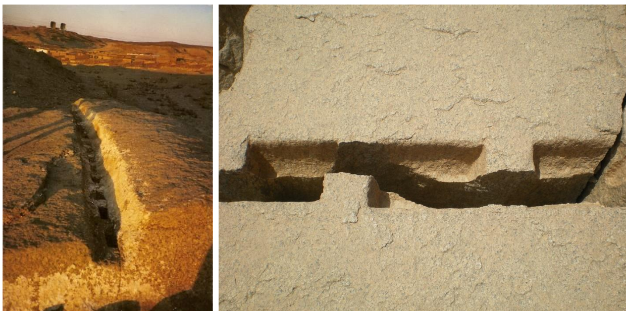
Trous de mortoises de grande taille, nombreuses et rapprochées
